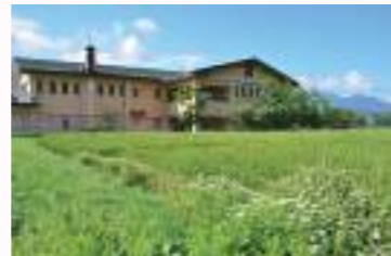
札幌市北方自然教育園 昭和51年6月開設 札幌市南区白川1814
